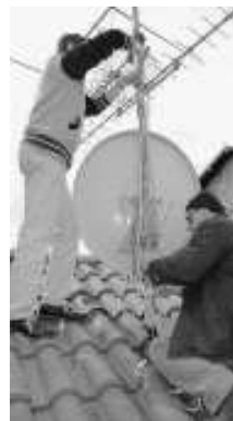
Due antennisti su un tetto mentre montano una parabola
