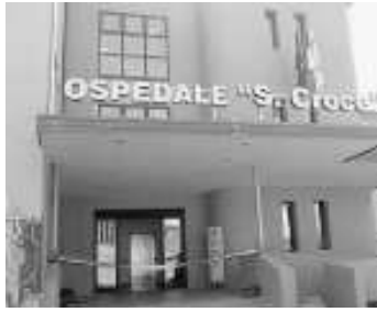
L'attuale ospedale di Castelnuovo
