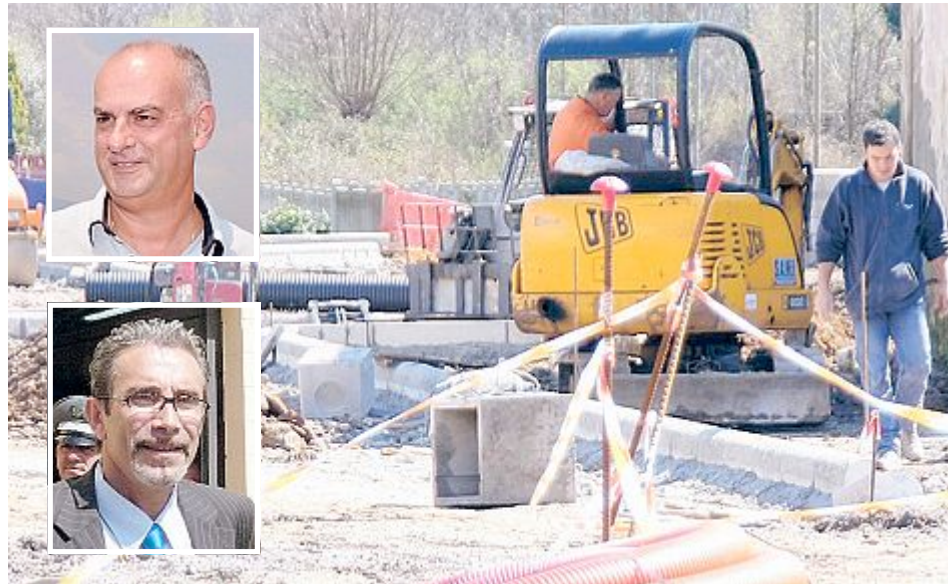
CANTIERI AL VIA Conclude le aste, sono stati assegnati i lavori. Grande soddisfazione per il sindaco Bonini (sopra) e l'assessore Onesti (sotto) (foto Borghesi)
